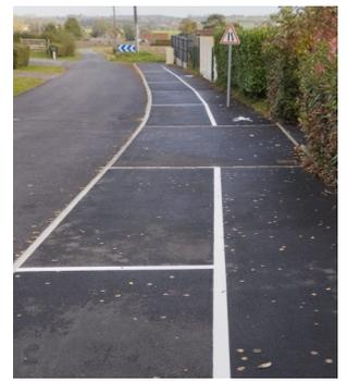
**Travaux terminés petite route de Steenvoorde : réfection du tapis d'enrobé et des trottoirs, signalisation**
